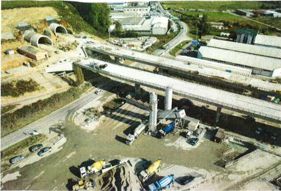
Höchste Qualität im Tunnelbau mit der EUROMIX 3300 SM 84 L von SBM (Foto: SBM Mineral Processing)
